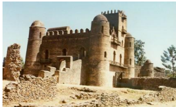
Fasil Castel: Gondar
